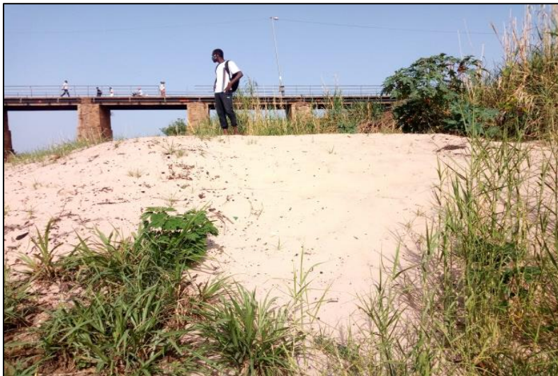
Photo 4. Banc de sables au niveau de l'ancien pont de la ville de Kara
